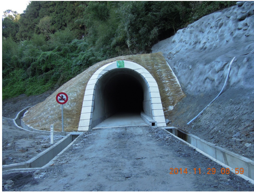
屏遮那隧道西口完工照
